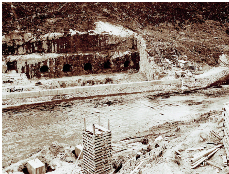
BERSIMIS EN CONSTRUCTION, 1957.
