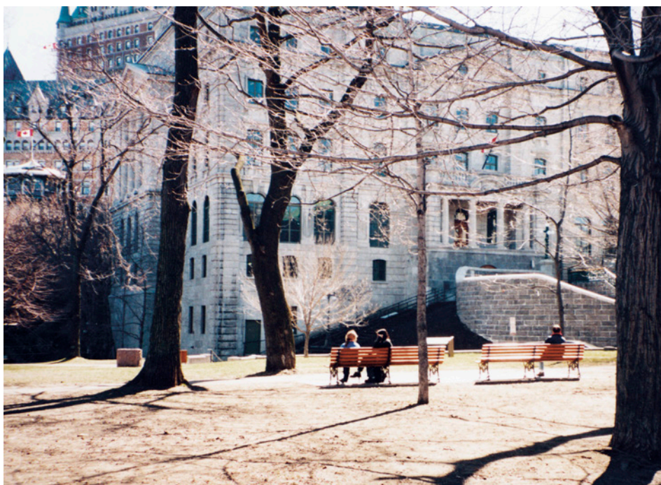
LE PARC MONTMORENCY ET L'HÔTEL DE LA POSTE, 1998. Photographie Marcel Bélanger.
