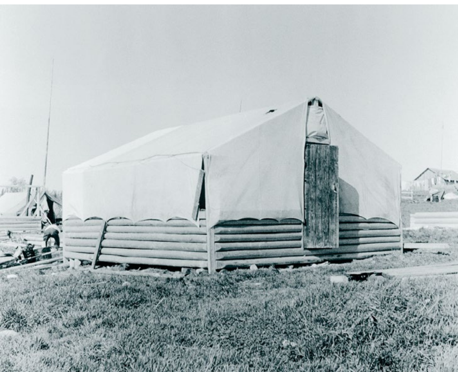
TENTE TYPIQUE DE WASWANIFI, 1955. LA BASE EST FAITE DE BILLOTS ÉCORCÉS ET LA CHARPENTE EST TENDUE DE TOILE. Archives nationales du Québec, M. B. Chouinard, E6, S7, P2002-55.
