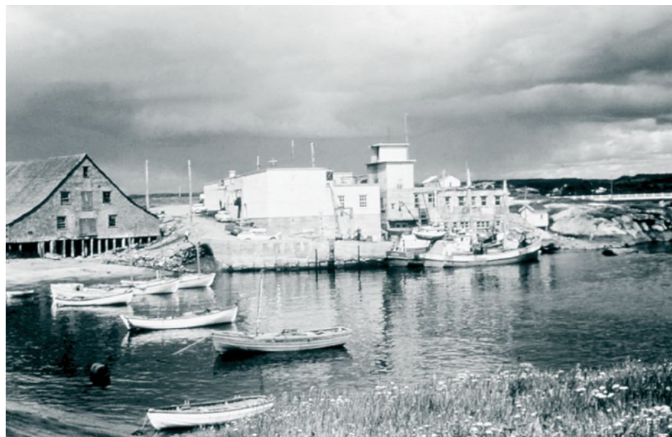
HANGAR JERSEYIS ET USINE DE POISSON, RIVIÈRE-AU-TONNERRE. Projet Ethnographie de la Côte-Nord, Université Laval.
