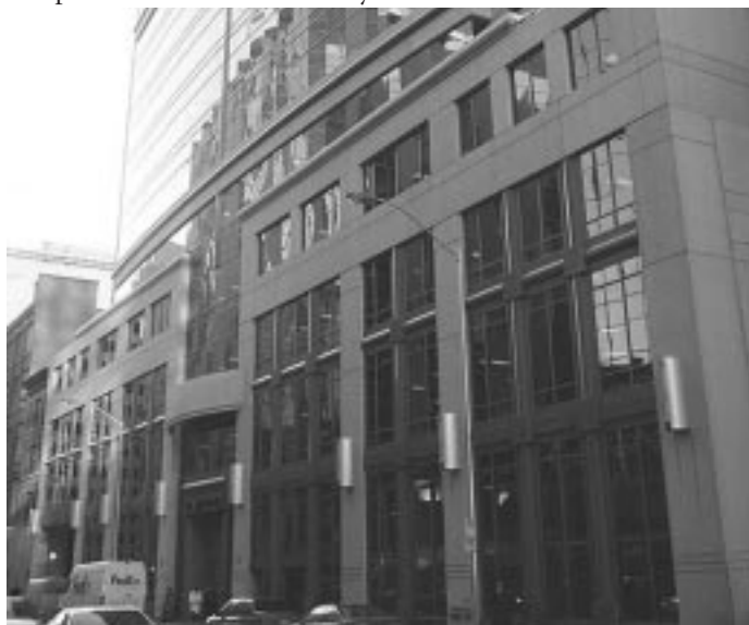
CBC building, Ottawa / Édifice de Radio-Canada à Ottawa
