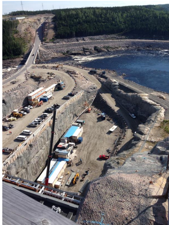
Photo 2 : Chantier de la rivière Romaine
