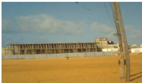
Mausolée de Seydina Issa Laye en restauration. Photo : Mountaga Diagne (2007)
